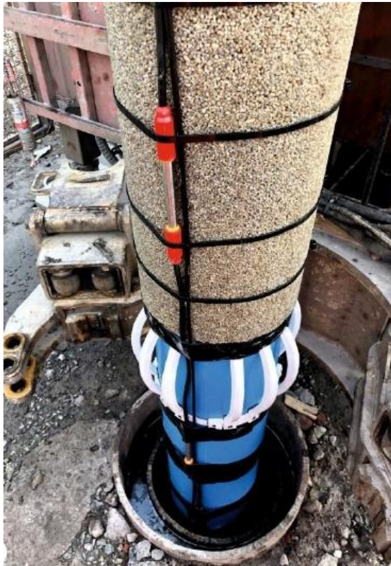
Рисунок 1.12 – Зображення блокового гравійного фільтра на фільтровій колоні
