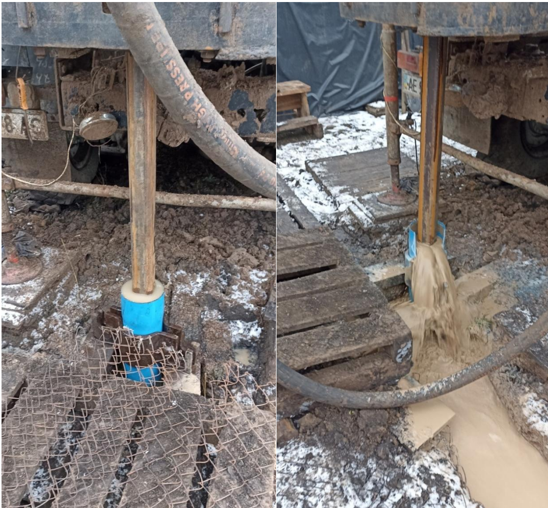
Рисунок 5.11 – Промивання свердловини через фільтрову колону
