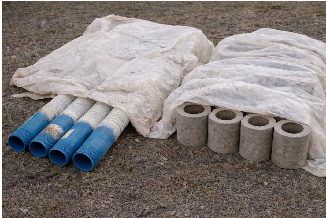
Рисунок 5.10 – Підготовка БГЕ фільтра для спуску у свердловину
