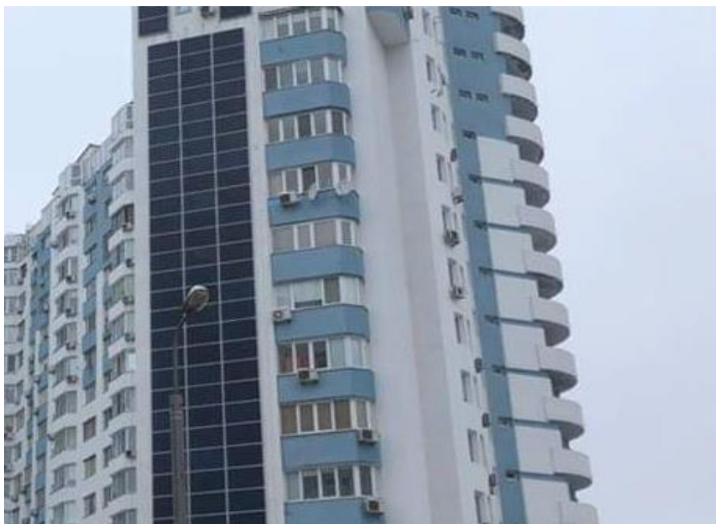
Рис. 1.1 Сонячна BIPV електростанція в м. Київ
