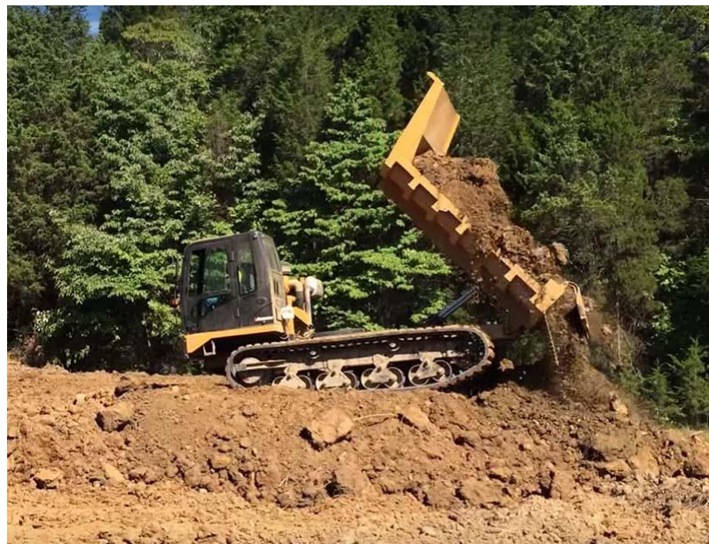
Рис. 1.9. Мароока на будівництві дороги.
