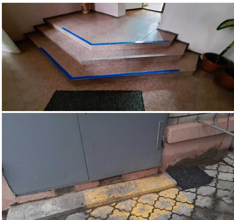
Рис. 2.11. Фотофіксація контрастного маркування на шляхах просування МГН.
