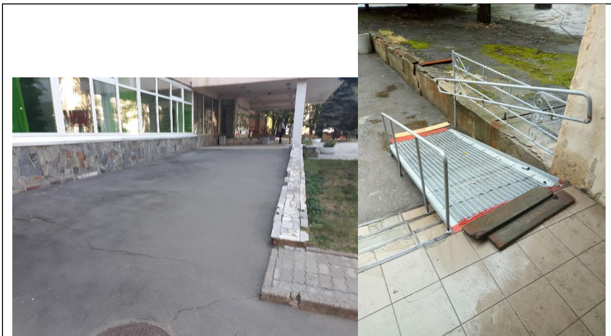
Фотоилл. 2 - Загальний вигляд пандусів
