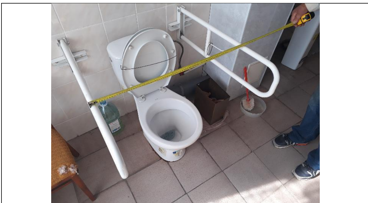
Фотоилл. 11 - Санітарно-гігієнічні приміщення
