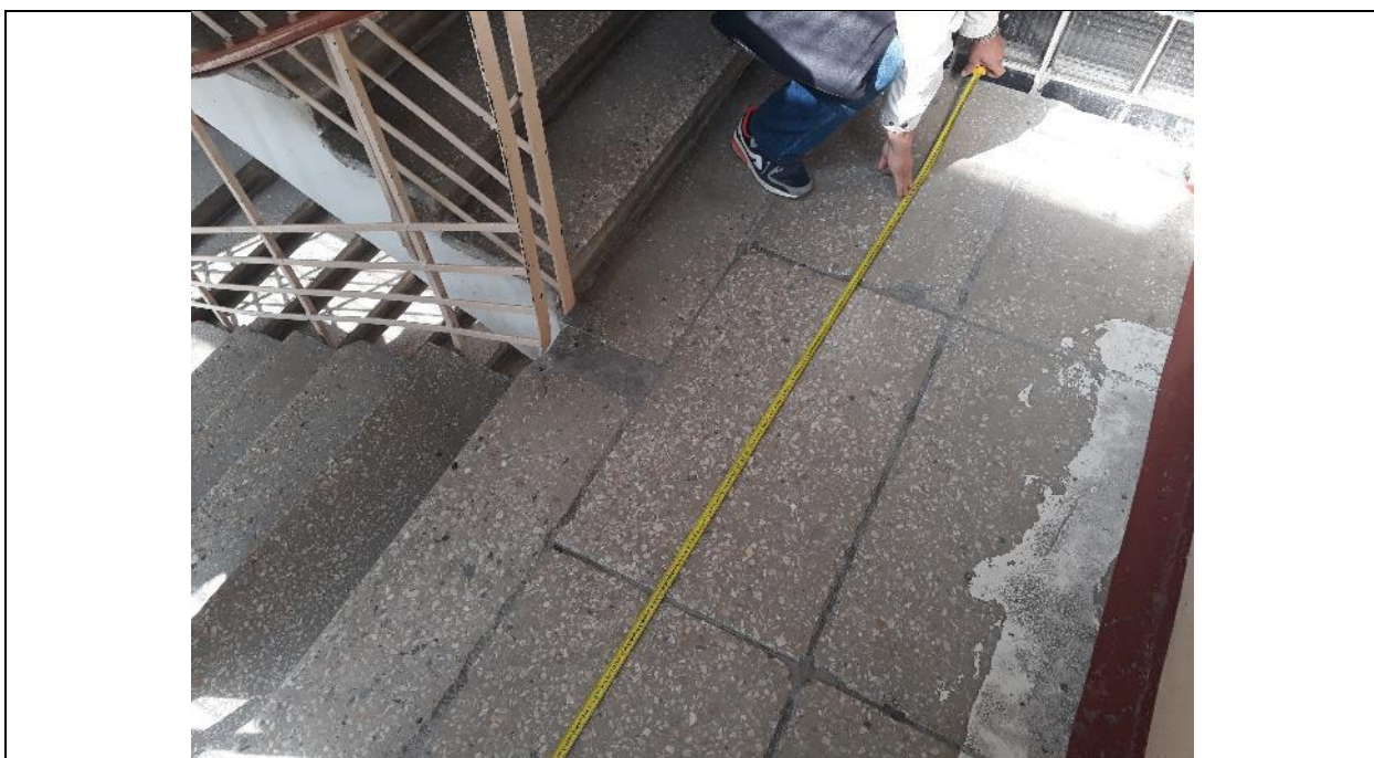
Фотоилл. 7 - Сходи внутрішні
